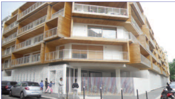
le nouvel immeuble du passage Delessert compte 69 logements sociaux un gymnase et une salle omnisports donnant sur un jardin intérieur
